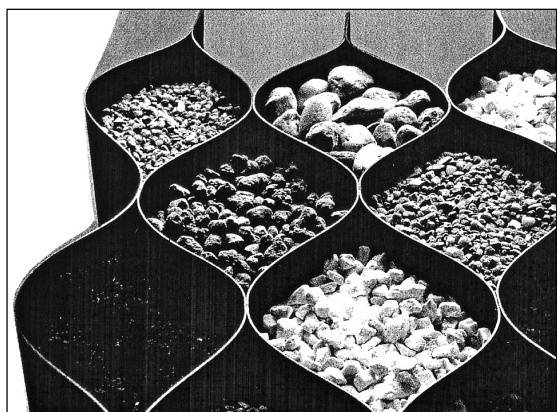
Rys. 2. Widok rozciągniętej na budowie geokraty z wypełnionymi komórkami kruszywem kamiennym
