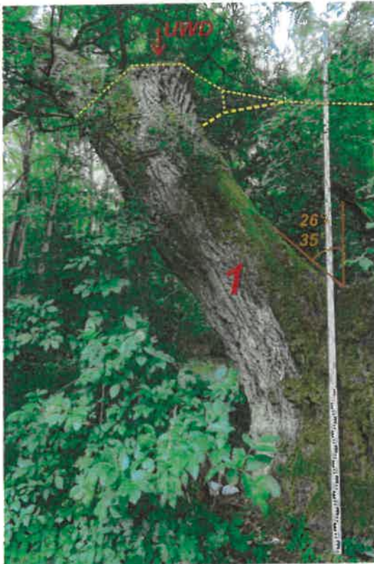
Fot. 5. Podstawa pnia przewodnikowego nr 1 (rozległy UWD, przebieg wiązania stal. linowego, kąt pochyl. przewodnika od pionu)
