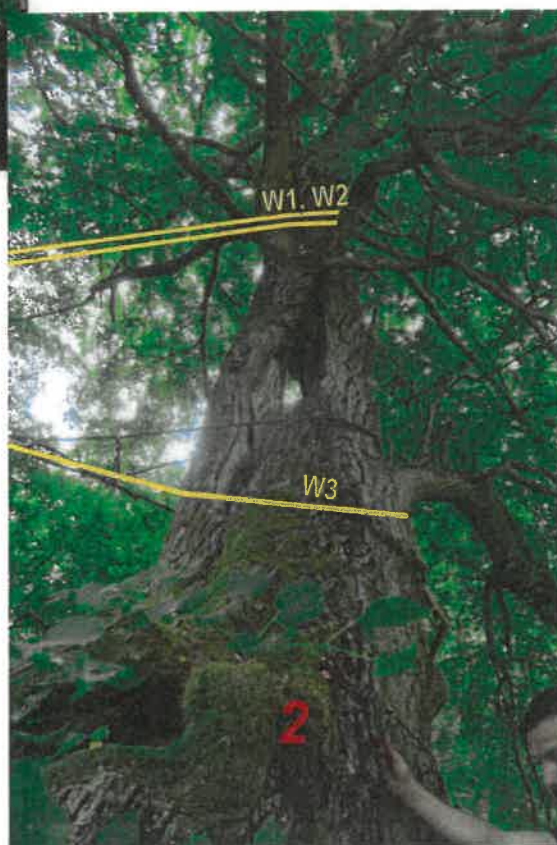
Fot. 6. Pień nr 2 od strony zach. - miejsca montażu wiązań statycznych: W1, W2, W3
